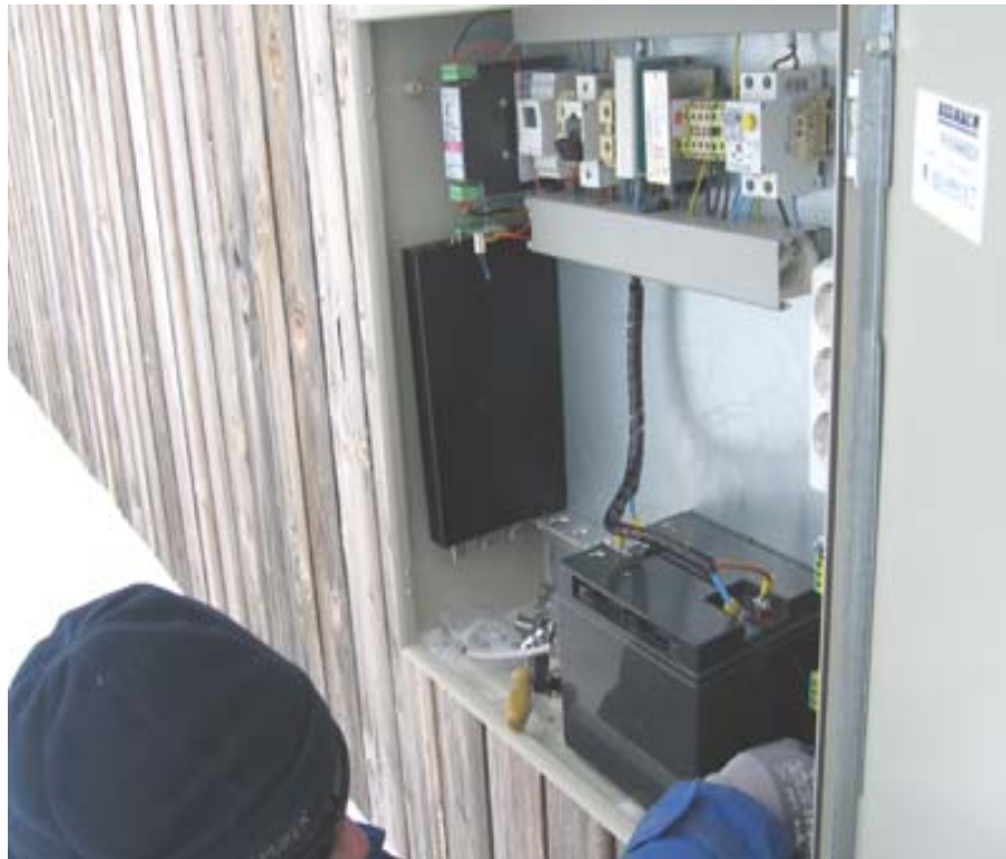
Ein Routerboard 600er Serie Mikrotik mit Funkkarten, im Einsatz am OE7XGR Hintertuxer Gletscher, 3200m Seehöhe
